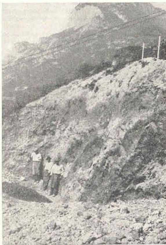
Fig. 2 - Dornach: profondi scassi nella « mittlere Steingleite » durante i lavori 1929-1931. Fotografia da Sud.
