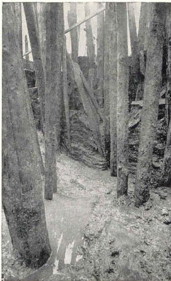
Fig. 2 - Fivè - scavi 1975; particolare della palificazione nel settore VIII con resti dell'antico crollo delle sovrastrutture.
